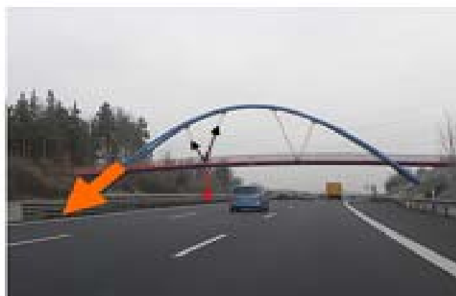
Rys.21.8 Most ma charakterystyczny kształt łuku. Łuki przenoszą ciężar sklepień całej budowli na fundamenty i grunt. "Wklęsły most" zawaliłby się po prostu pod wpływem ciężkości. W prostej belce siła ciężkości skierowana jest do środka, to też nie jest najlepsze rozwiązanie. Zastosowanie łuków znali już starożytni, budując np. Koloseum.
