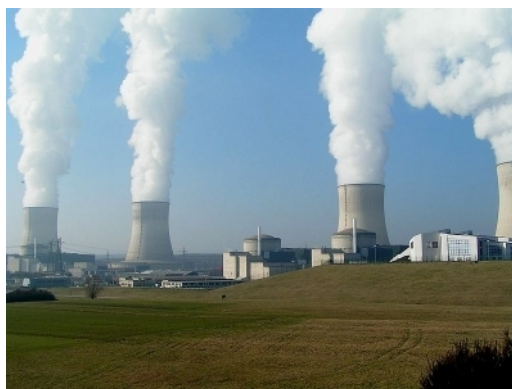
Rysunek 5.3. Kolumny w elektrowni jądrowej, w których jest chłodzony czynnik roboczy napędzający reaktor. Dym wydostający się z kominów to para wodna, czyli emisyjność CO 2 wynosi 0% (źródło: Wikipedia, Électricité de France)
